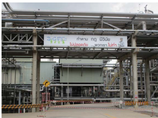
รูปที่ 3.1-1 (รูปที่ 86 ท่อรับส่งวัตถุดิบ-ผลิตภัณฑ์วางตัวบน Pipe Rack และ Pipe Bride)
