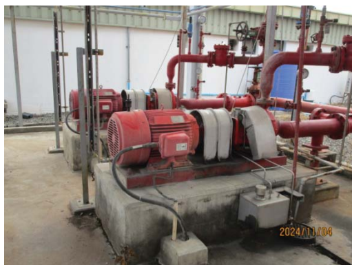
รูปที่ 3.1-1 (รูปที่ 84 ปั้มน้ำดับเพลิง แบบไฟฟ้า)
