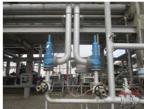
รูปที่ 3.1-1 (รูปที่ 89 Safety Valve บนท่อขนส่ง)
