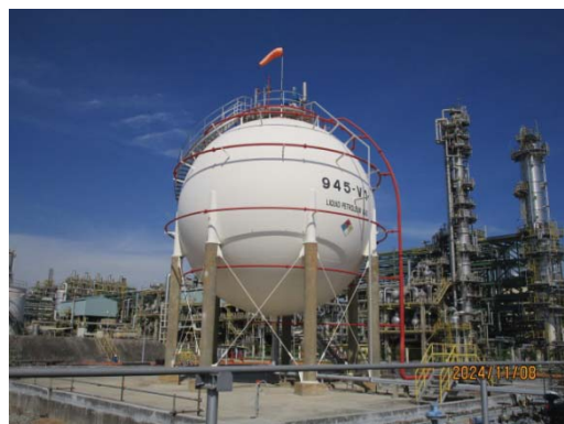
รูปที่ 3.1-1 (รูปที่ 85 ระบบฉีดพรมน้ำ บริเวณถังเก็บสำรอง)
