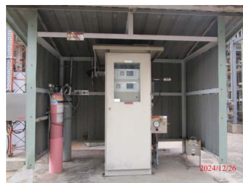
รูปที่ 3.1-1 (รูปที่ 4) อุปกรณ์การตรวจวัดการระบายมลสารจากปล่องอัตโนมัติ (CEMs))
