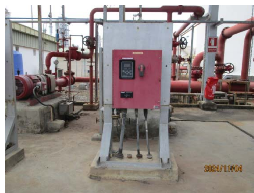
รูปที่ 3.1-1 (รูปที่ 80 Jockey Pump)
