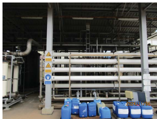
รูปที่ 3.1-1 (รูปที่ 28 ระบบ UF&RO)
