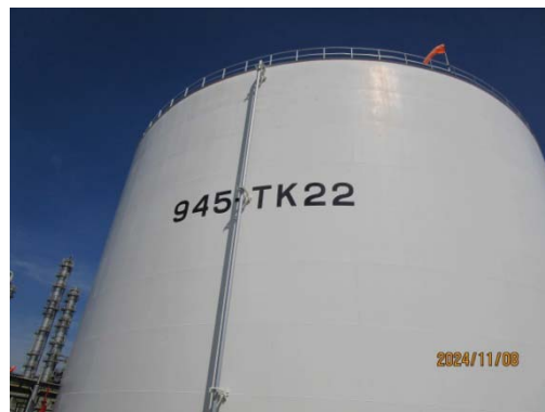
รูปที่ 3.1-1 (รูปที่ 75 ถังเก็บน้ำดับเพลิง)
