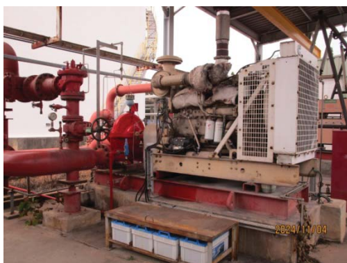
รูปที่ 3.1-1 (รูปที่ 79 ปั้มน้ำดับเพลิง แบบ Diesel Pump)
