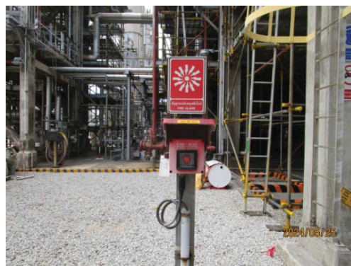
รูปที่ 3.1-1 (รูปที่ 66 Manual Call Point)
