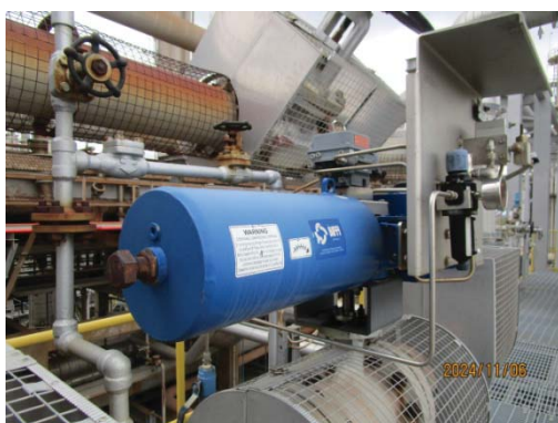
รูปที่ 3.1-1 (รูปที่ 90 Remote Shut-off Valve)
