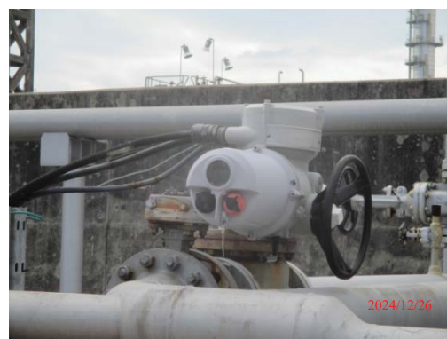
รูปที่ 3.1-1 (รูปที่ 90 Remote Shut-off Valve)
