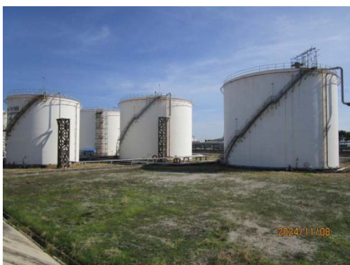
รูปที่ 3.1-1 (รูปที่ 5 ดังเก็บสำรอง ไฮโดรคาร์บอนชนิด IFRN และชนิด CRN)
