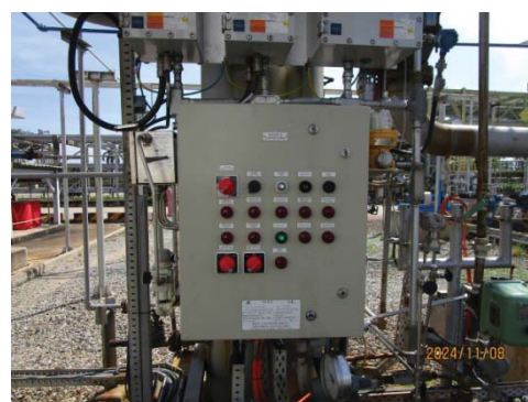
รูปที่ 3.1-1 (รูปที่ 64 แผงควบคุมระบบ การเผาไหม้สารไฮโดรคาร์บอน)
