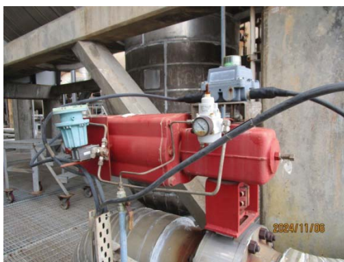
รูปที่ 3.1-1 (รูปที่ 91 On-Off Valve)
