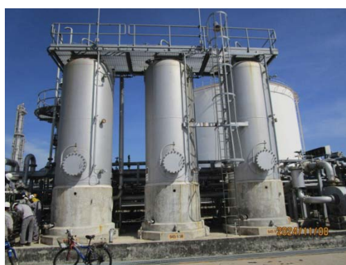
รูปที่ 3.1-1 (รูปที่ 8 Vapor Recovery Unit)
