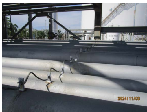
รูปที่ 3.1-1 (รูปที่ 88 สายดินบริเวณท่อขนส่ง)
