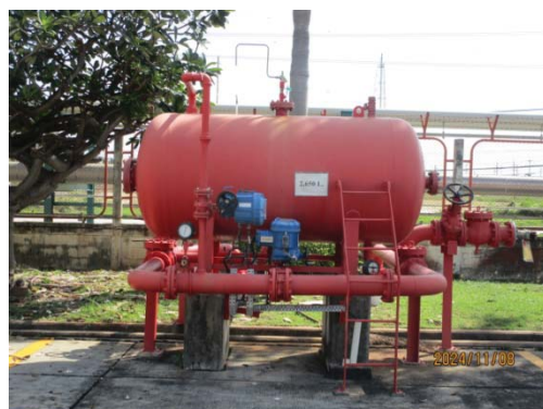
รูปที่ 3.1-1 (รูปที่ 73 ระบบโฟมดับเพลิง)
