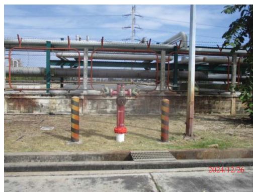
รูปที่ 3.1-1 (รูปที่ 76 Water Hydrant)
