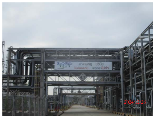
รูปที่ 3.1-1 (รูปที่ 86 ท่อรับส่งวัตถุดิบ-ผลิตภัณฑ์วางตัวบน Pipe Rack และ Pipe Bride)
