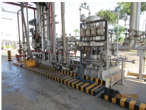
รูปที่ 3.1-1 (รูปที่ 70 Vapor Return Arm บริเวณ Loading Rack)
