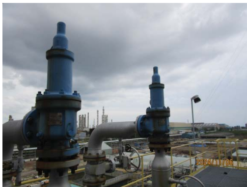
รูปที่ 3.1-1 (รูปที่ 89 Safety Valve บนท่อขนส่ง)
